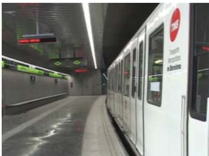
Estación Casa de l'Aigua
