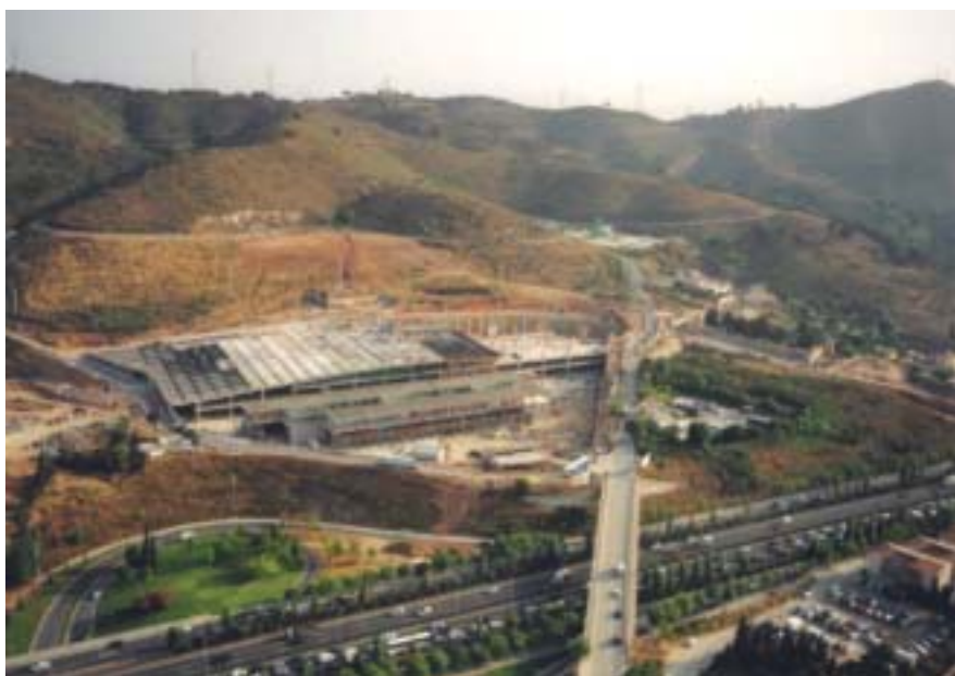
Foto 3. Vista general construcció cotxera d'Horta
