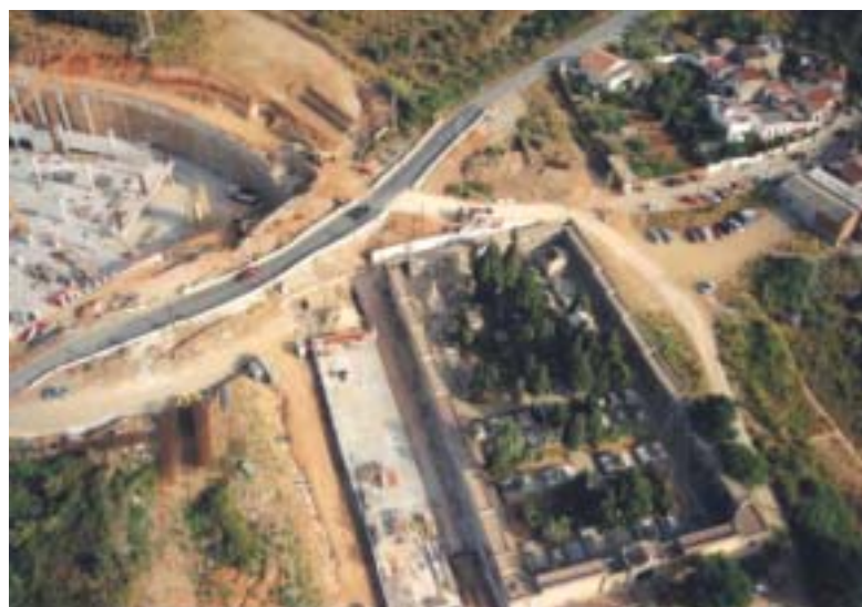
Foto 5. Obres dels accesos viaris a la cotxera d'Horta.
