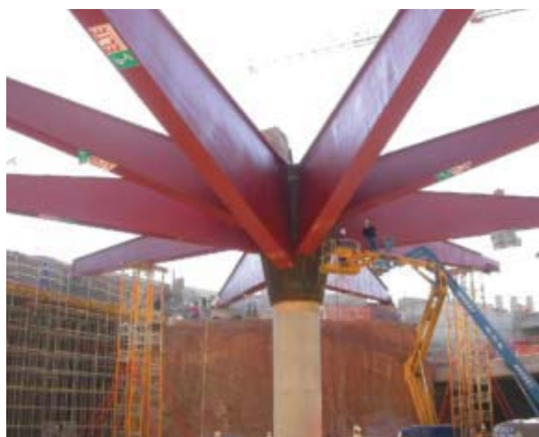
Foto 6. Estructura suport de la rotonda de la llosa d'entrada a la cotxera d'Horta.
