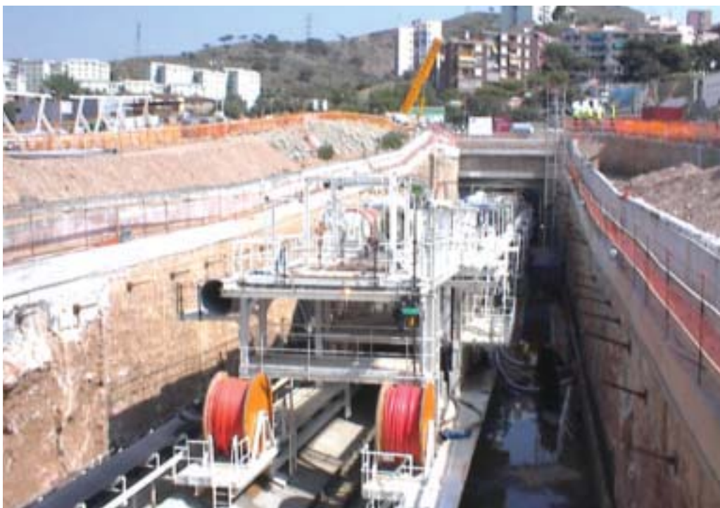
Vista longitudinal de la tuneladora vista desde enrrera.
