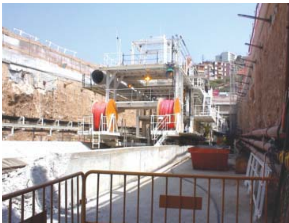
Vista parcial de la tuneladora
