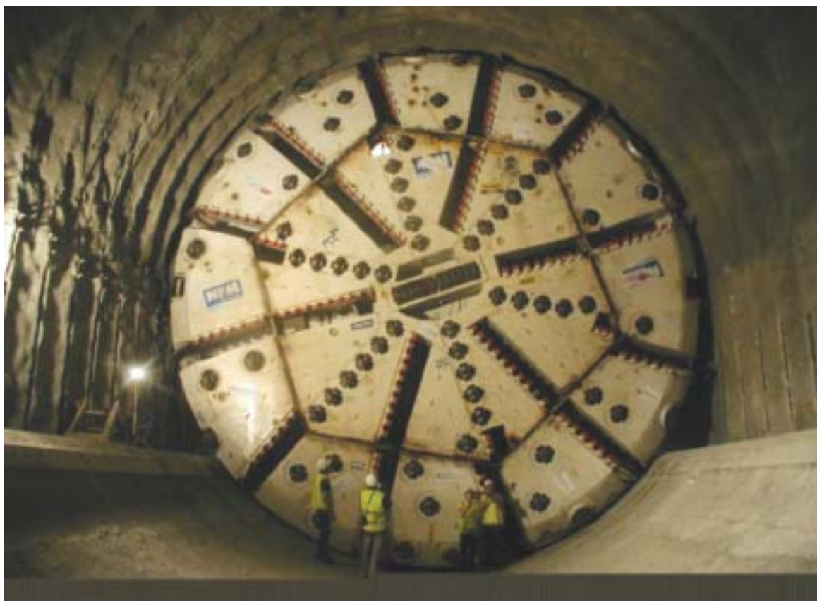
Escut de la tuneladora de 12.06 metres de diàmetre
