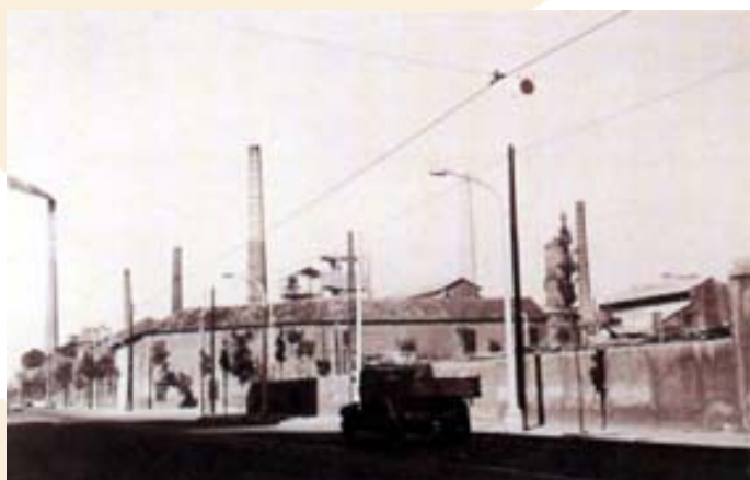
Instal·lacions de Macosa.
