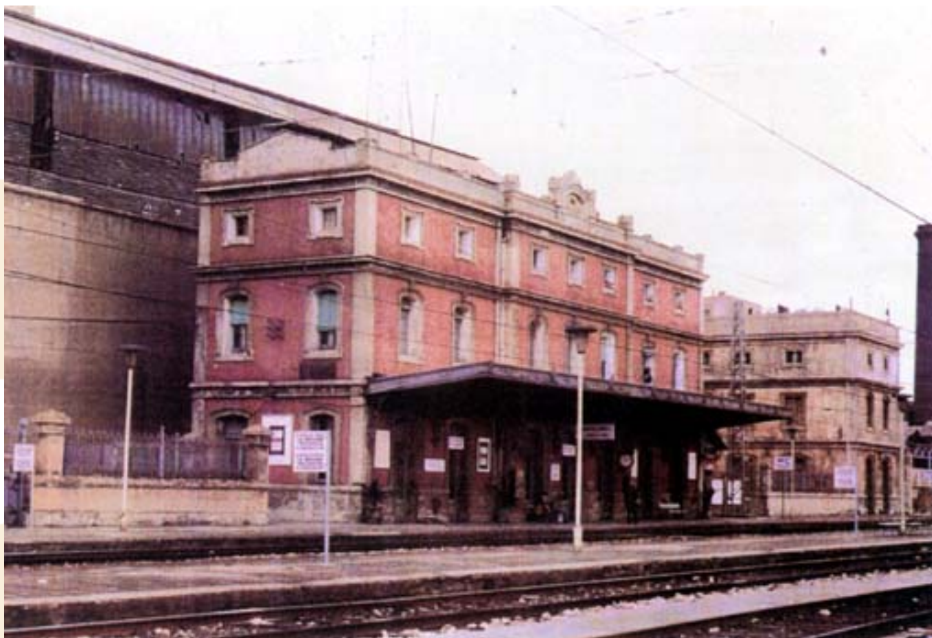
L'estació de Poble nou, enderrocada el 1992.
