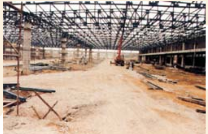
Aspectes diferents de la construcció del taller PMO III.
