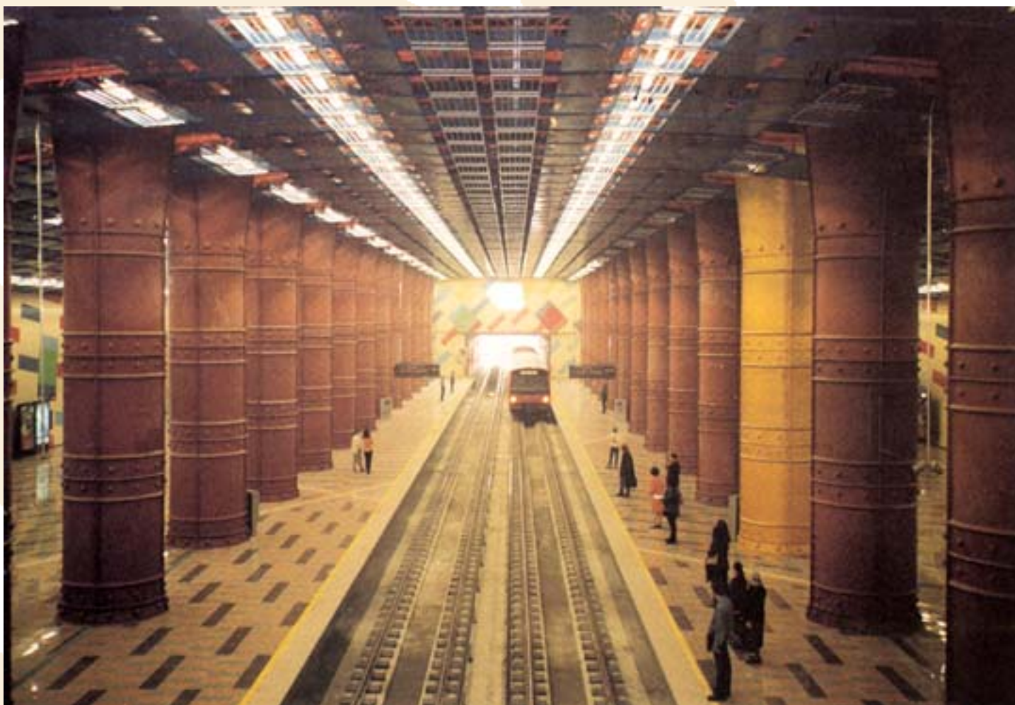
Estació OLAIAS de la línia de l'EXPO
