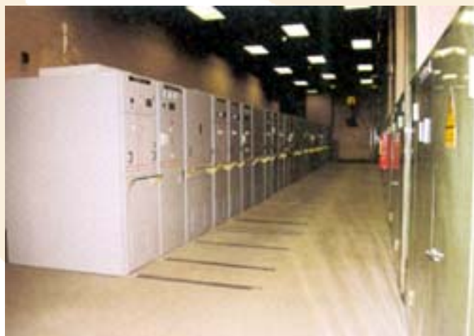
Renovación/ampliación S.C. Verdaguer. Vista parcial.
