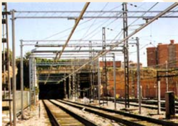
Detalle instalación catenaria rígida en Boixeres.
