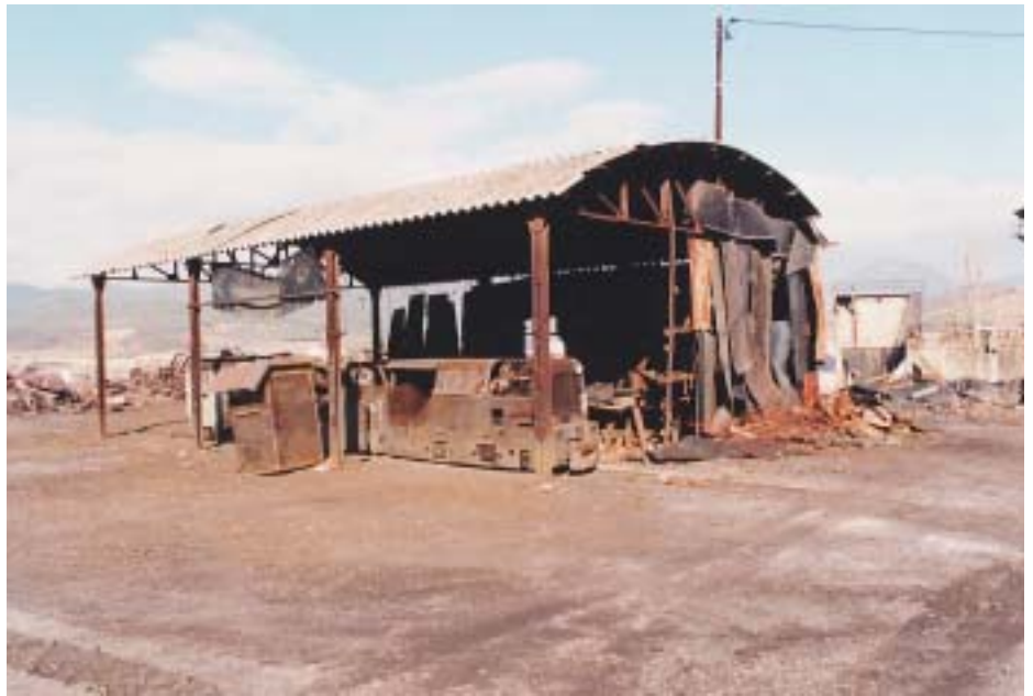
Cocherón de locomotoras abandonado en la Mina Julia, en donde se encuentran ya sin servicio dos locomotoras Orenstein & Koppel. Daniel Pérez Lanuza. (28/1/00)
