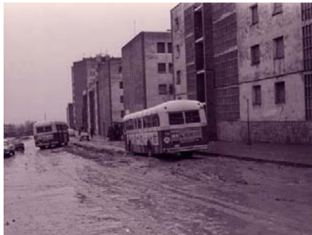
Durante los años 60 muchos barrios carecían de accesos en condiciones. Els Merinals era uno de ellos. La línea 4 se abre paso en el barrizal provocado por una tormenta. Foto: P.Farrán
